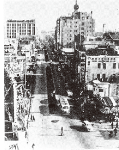
同上軌道撤去後
