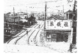
新宿2丁目付近工事中
